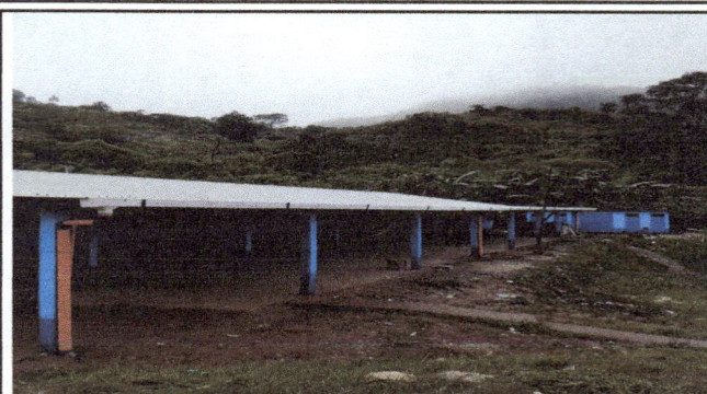
Foto 2: Colocación de canales
