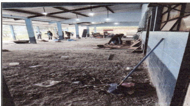
Foto 3: Colocación de pisos en el corredor
